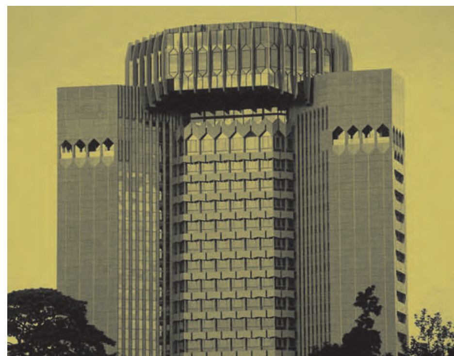
Services Centraux de la BEAC à Yaoundé
